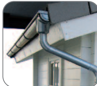
Zink- und Kupferdachrinne mit Fallrohren.
