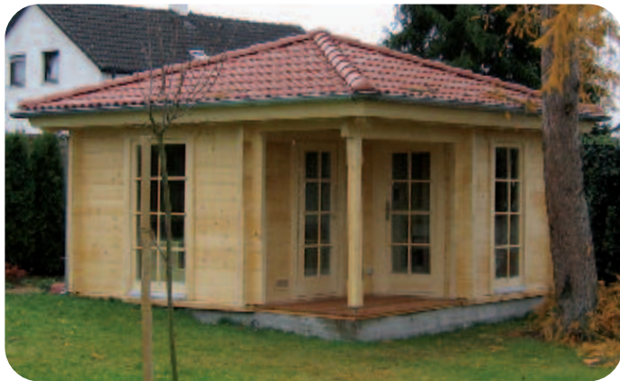
Außensaunen mit Walmdach
