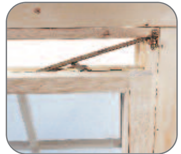
Alle Fenster haben verdeckte Einhanddrehkippbeschläge. Echthverglasung 4 mm, ab 50 mm Isolierverglasung, aufgeschraubte Sprossen und eine Aluminium-Regen-ablaufschiene. Die Außenblende ist gerade.
