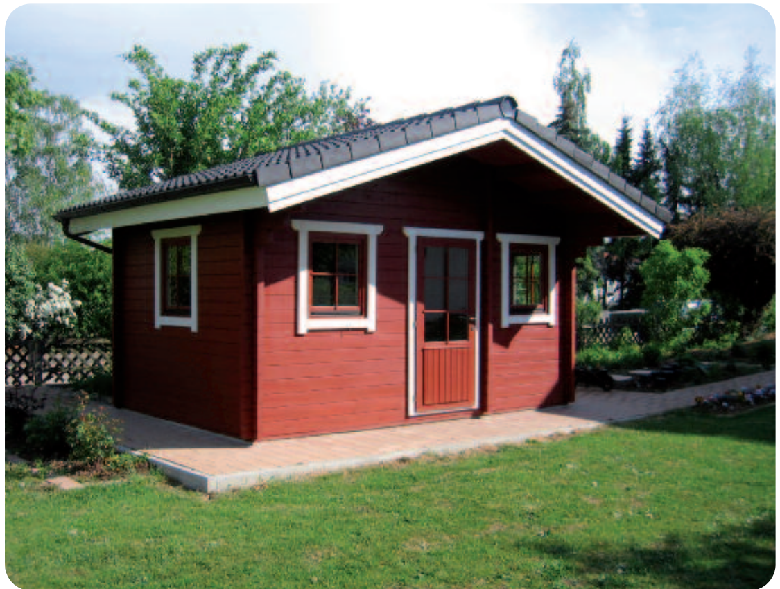
Country 11/3, Abbildung mit 70 mm Wandstärke, geraden Blenden und individueller Farbgestaltung
